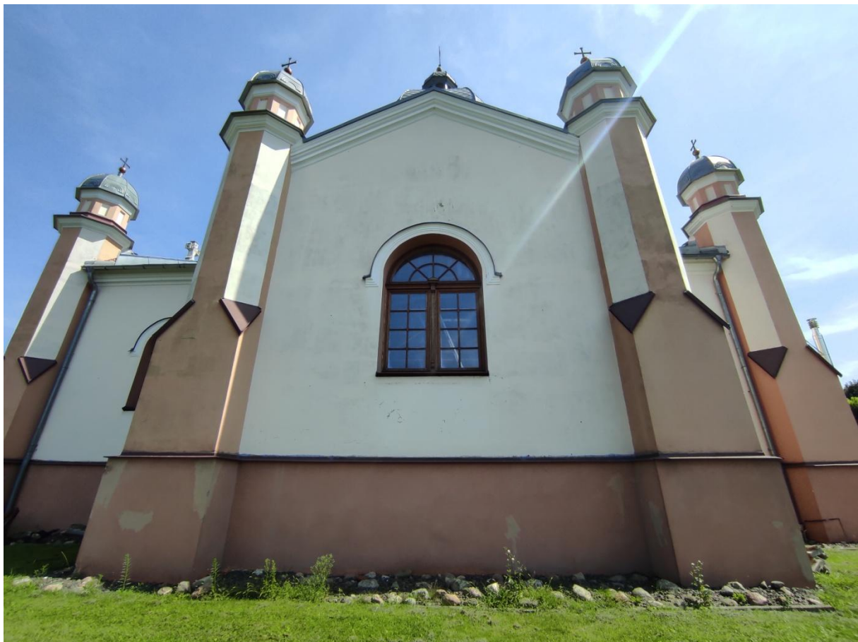
Fot. Nr5. Zabytkowy kościół w Kuryłówce. Widok ogólny - strona południowa
