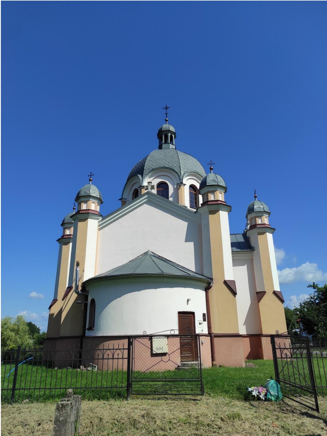
Fot. Nr3. Zabytkowy kościół w Kuryłówce. Widok ogólny - strona wschodnia
